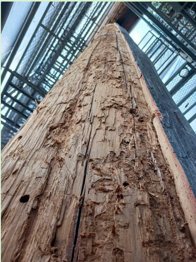
柱の劣化部分を削り取る
