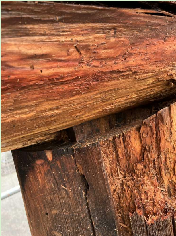
笠木と柱の繋ぎ部
