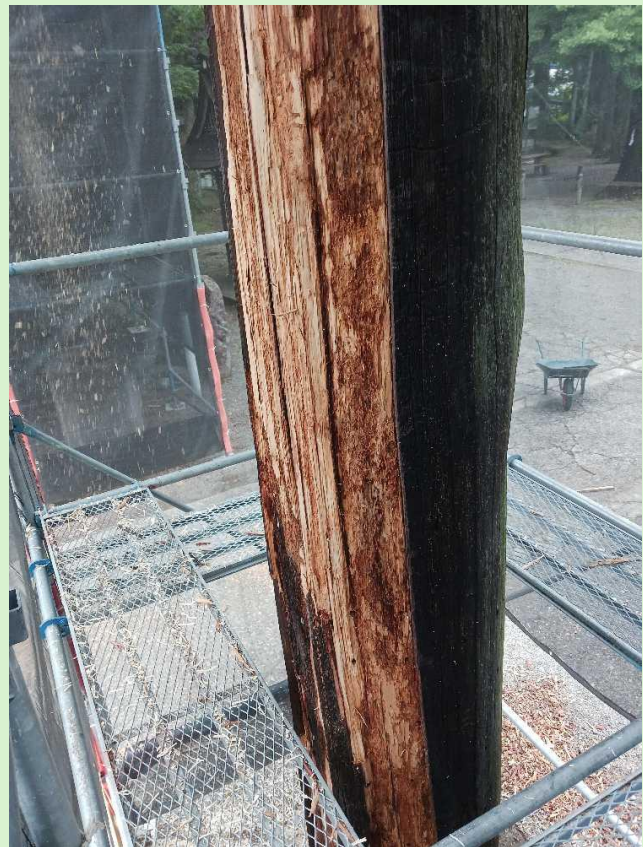
柱の劣化部分を削り取る
