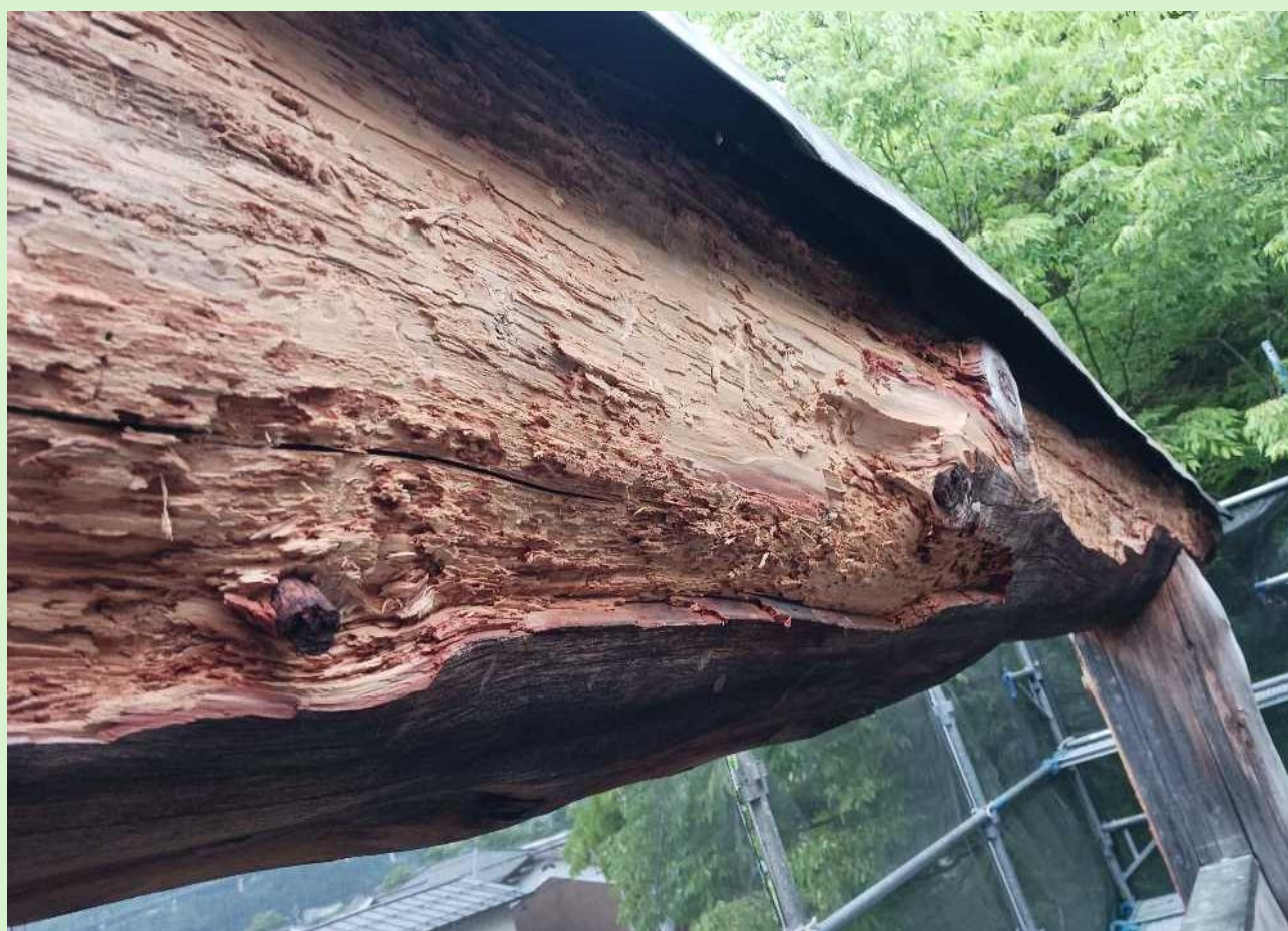
笠木劣化箇所剥ぎ取り状況
